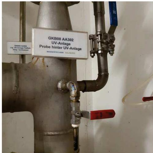
Abb 4: PN-Hahn nach UV-Desinfektion
